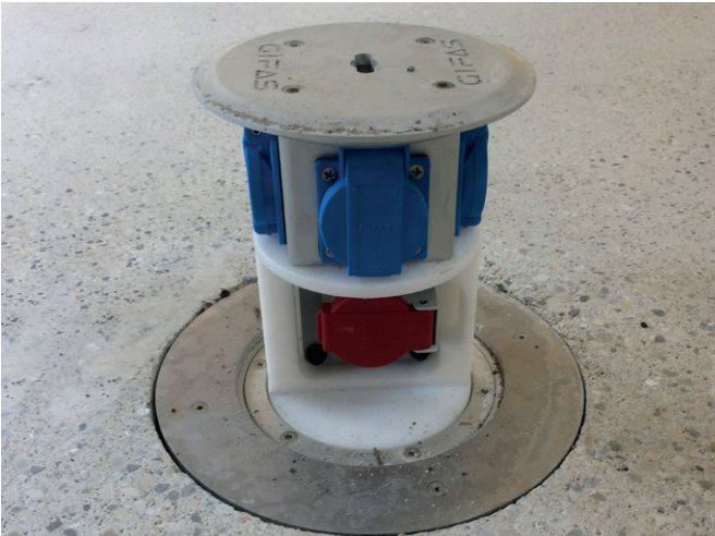
Pavimento in cemento
